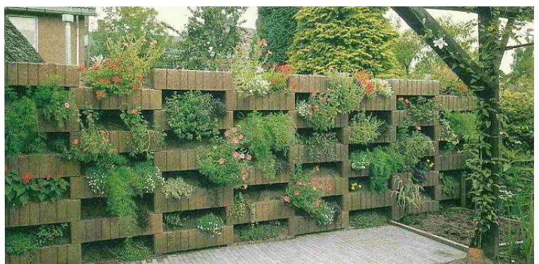
FOTO 2 - paramento in fase di inverdimento
